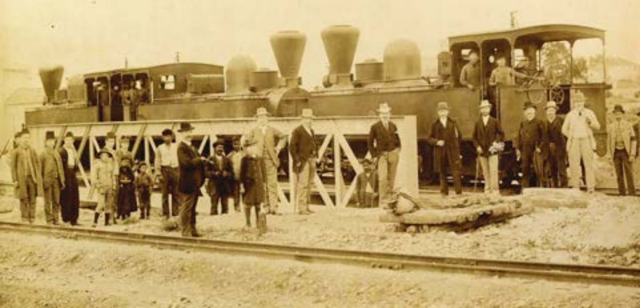
Δοκιμή αντοχής γέφυρας των Σιδηροδρόμων Θεσσαλίας (Βόλου - Καλαμπάκας) το 1886.
