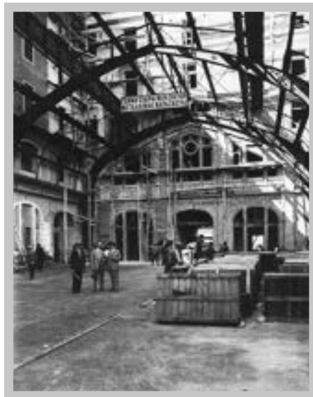
Η κατασκευή του σιδηροδρομικού σταθμού στον Πειραιά το 1926 (αρχεία ΗΣΑΠ).
