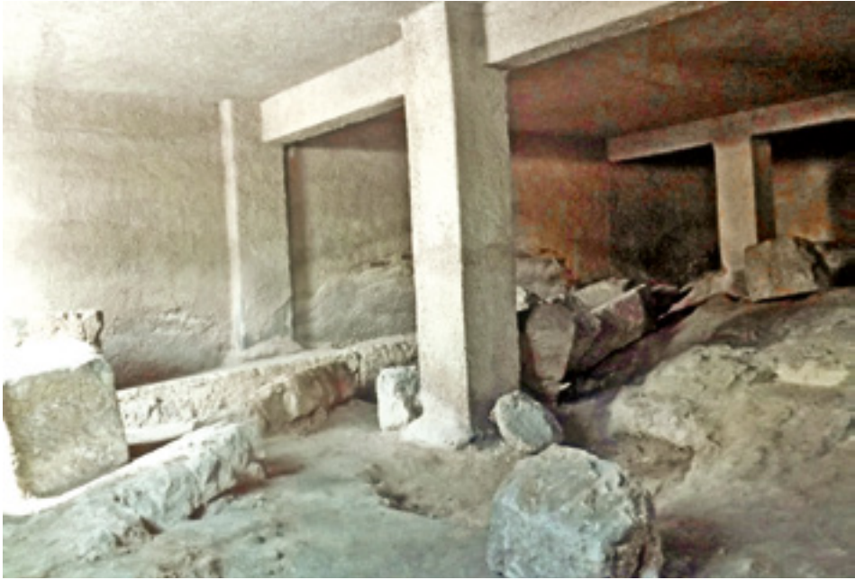
Τμήμα νεωσοίκων στο υπόγειο σύγχρονης πολυκατοικίας στη συμβολή των οδών Ακτής Μουτσοπούλου και Συραγγείου.
