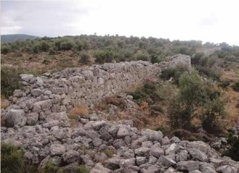
Τείχος Δέμα, Άνω Λιόσια, μέρος της οχύρωσης Πάρνηθας-Αιγάλεω.
