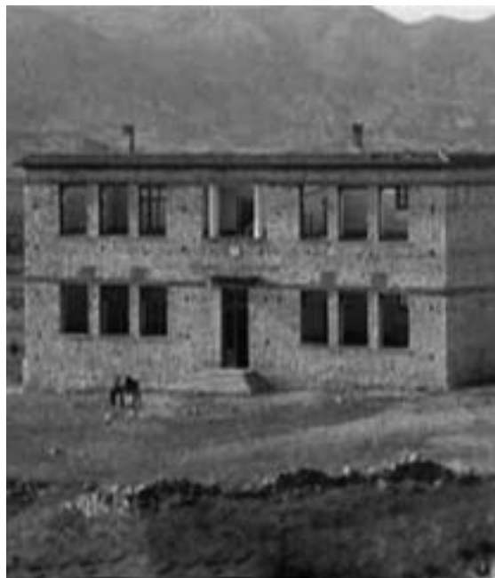
Το Δημοτικό Σχολείο Δομένικου μετά την καταστροφή του από τους Ιταλούς (Αρχείο Στάθη Ψωμιάδη).
