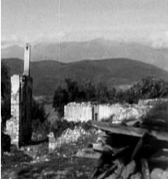
Κατεστραμμένα σπίτια στο Δομένικο (Αρχείο Στάθη Ψωμιάδη).
