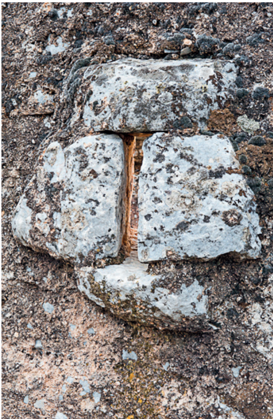
Τέσσερις στενόμακρες πέτρες κάθετα εντοιχισμένες, τείνοντας να συναντηθούν: πολεμίστρα στον ελληνικό Κάτω Λατόμ (1881), μεταξύ Δαμασίου και Πηνειού ποταμού.
