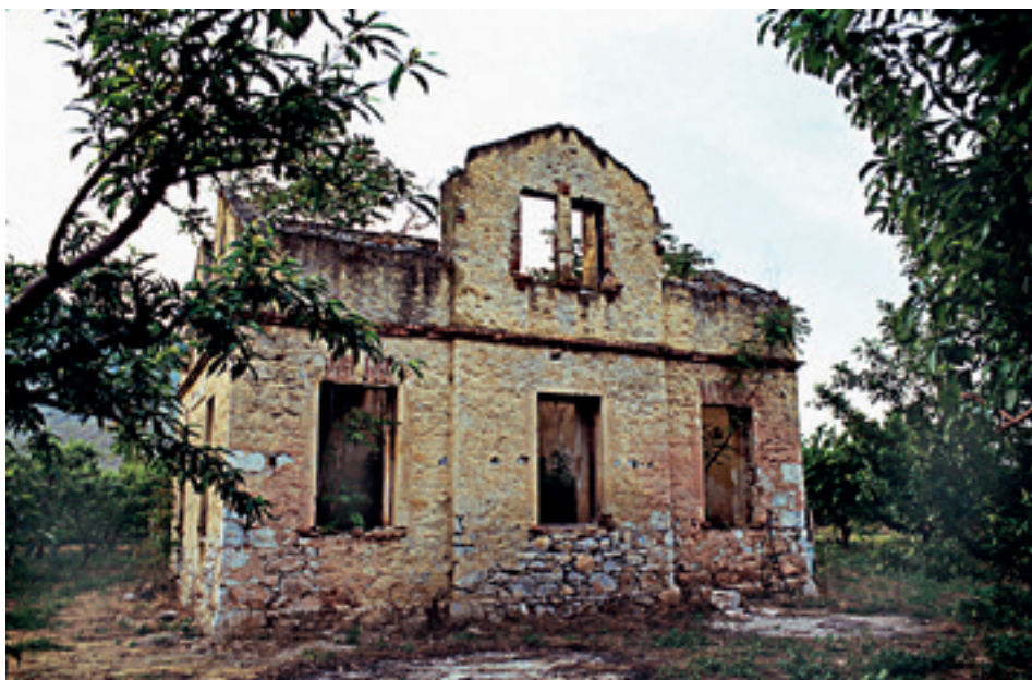
Το ελληνικό τελωνείο στο Μπογάζι (1881 και 1897) λίγο έξω από τον Τύρναβο, στη βόρεια όχθη του ποταμού Τιταρήσιου. Στο εσωτερικό των τοίχων, ψηλά στο ταβάνι σώζονται υπόνοιες γαλάζιας επίχρωσης από την εσωτερική διακόσμηση. Το αντίστοιχο οθωμανικό κτίσμα έχει κατεδαφιστεί.
