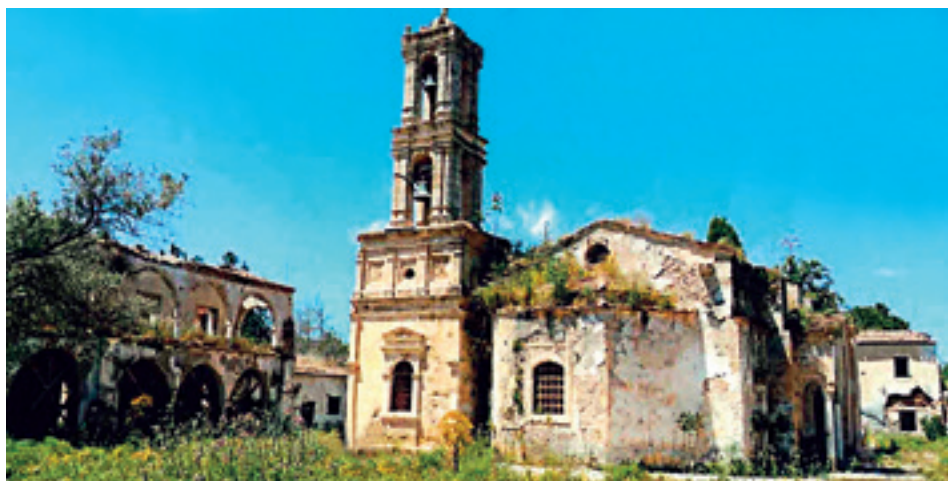
Άποψη του καθολικού και των κελιών της Μονής του Αγίου Παντελεήμονα Μύρτου στην Κερύνεια, πριν την έναρξη των εργασιών αποκατάστασης.
